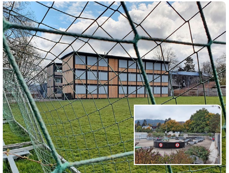
Durch die Schulpavillons wurde der Fussballplatz auf der Schulanlage Küngematt verkleinert (grosses Bild); eine neue Trainingsmöglichkeit soll eine stillgelegte Eisfläche im Sportzentrum Heuried bieten. Sie wird aktuell noch zwischengenutzt (kleines Bild).
